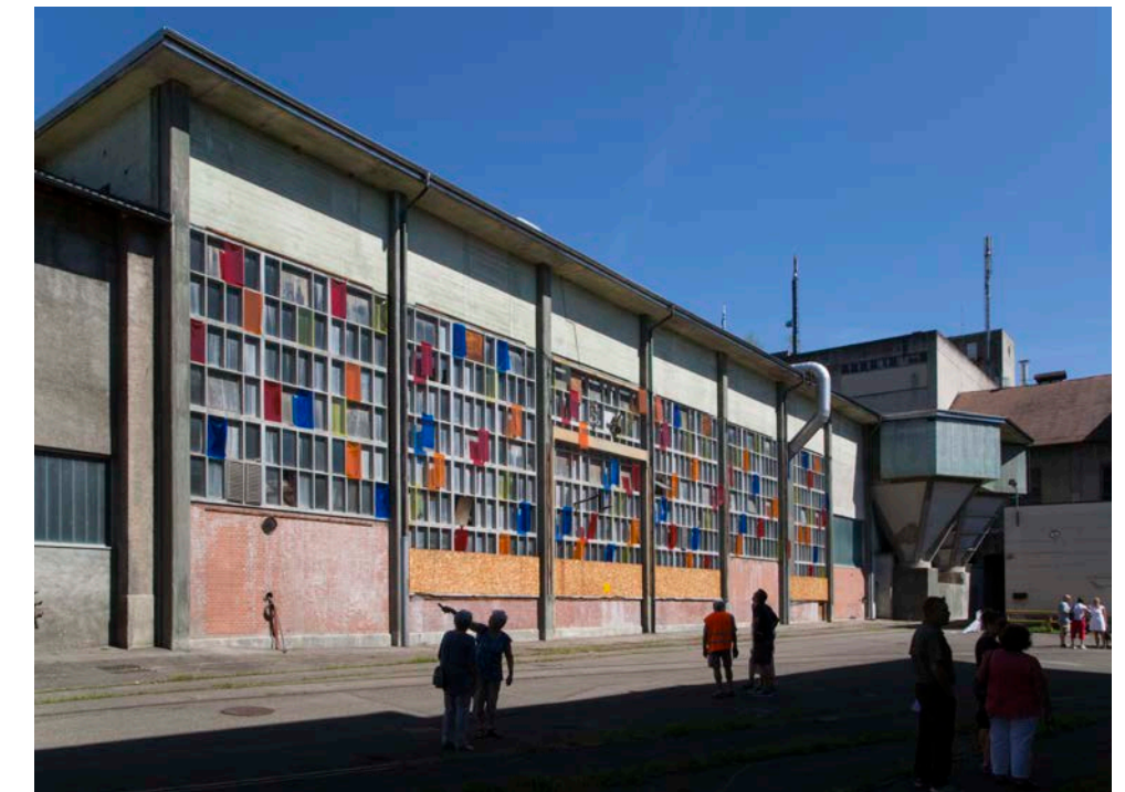
15'504 PVC-Folie (blau, gelb, orange, rot), Kabelbinder ca. 7x35m 2015
